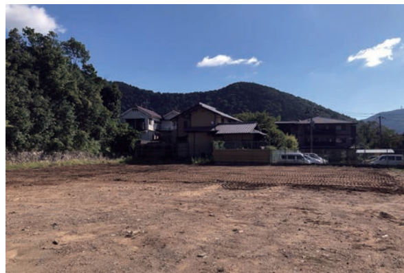
8. 調査終了状況
