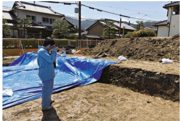
4. 遺構検出後の検査
