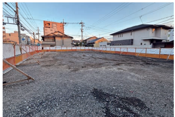
8. 調査終了状況
