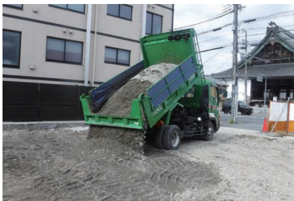
7. 整地用碎石の搬入
