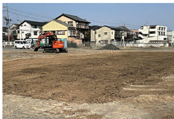
8. 埋戻し・調査終了状況
