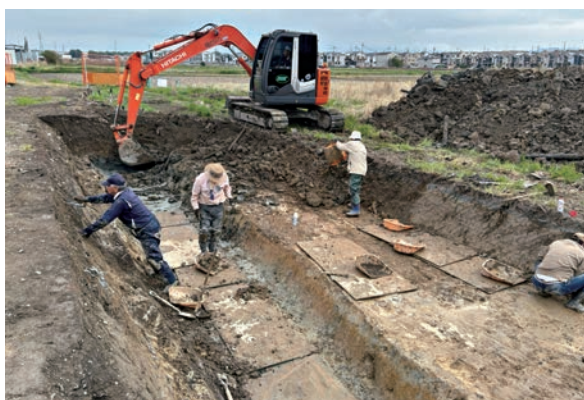
3. 遺構掘削作業
